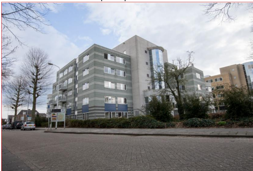
Afbeelding 37. 68 flexwoningen in Eindhoven in 2017 getransformeerd schoolgebouw
