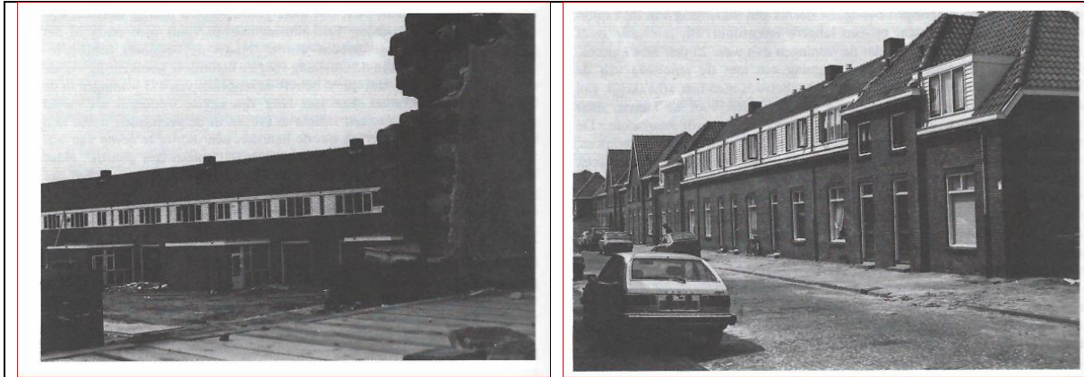
Afbeelding 29a en b. Renovatie Bloemenbuurt Gevels aan achterzijde opgetrokken en bergingen toegevoegd (links); renovatie voorzijde bijna voltooid (rechts) (Bron, Otten 1987, blz. 120)
