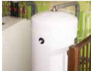
Boilervat 200L voor warm water
